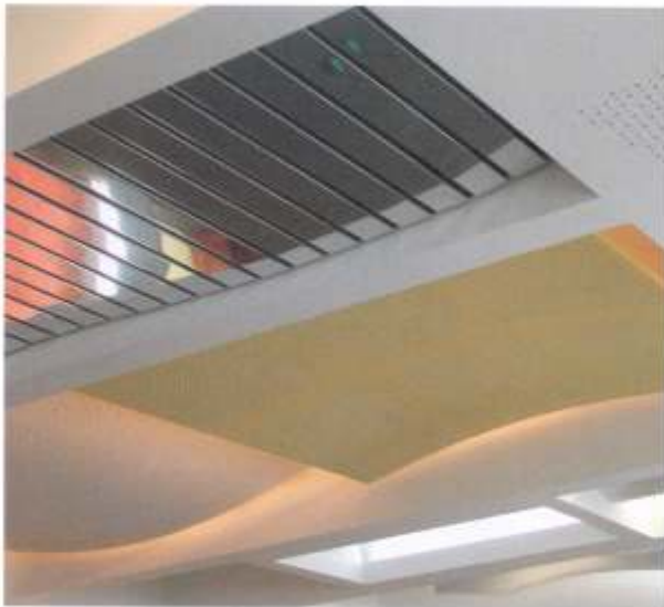
1 Decken in allen Varianten zeigt Stuckateurmeister Michael Bleich in seinem Ausstellungsraum.
