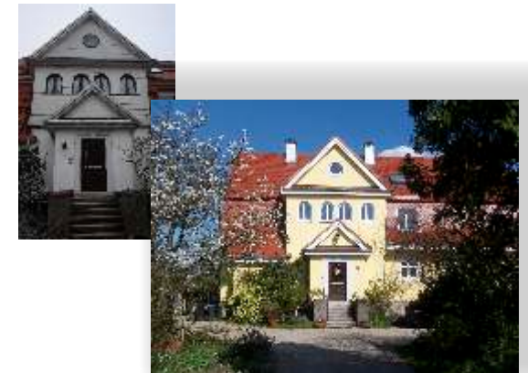
Die Eternitplatten sind gewichen, die neue energiesparende Fassade setzt neue Akzente.
