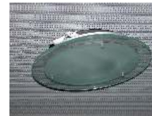
Deckenlampe, Lose nach dem Wechsel der Leuchtmittel.
